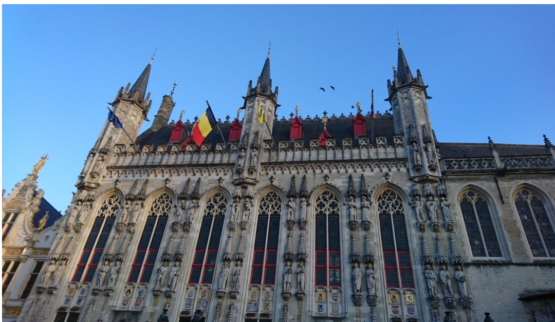
市庁舎 1420 年竣工で、ブルージュでもっとも古いといわれる建物。 おおっ古都ブルージュよ、そなたを『屋根のない美術館』と称えよう。
