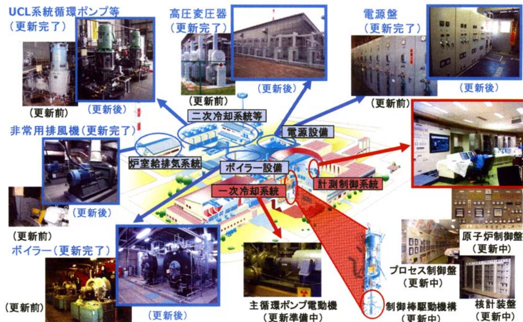
図 2. 原子炉機器の更新状況
