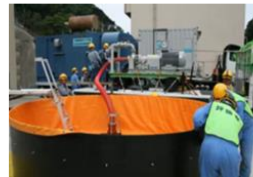
既設炉における現場でのラインアップ作業の例
