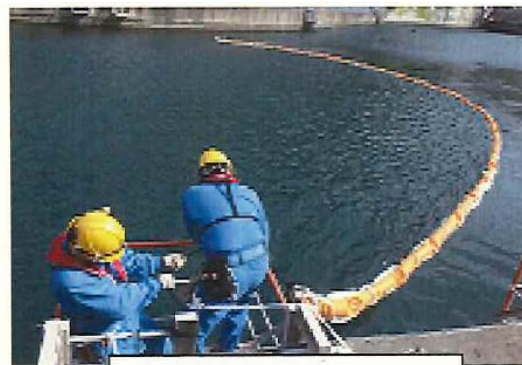
シルトフェンス設置
