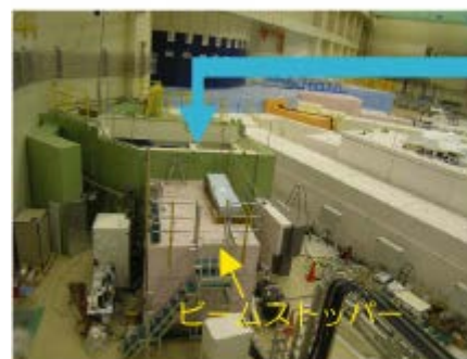
施設運転停止中のメンテナンス作業 (平成21年4月6日撮影)
