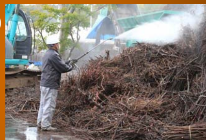
② 処理前の飛散防止の水まき
