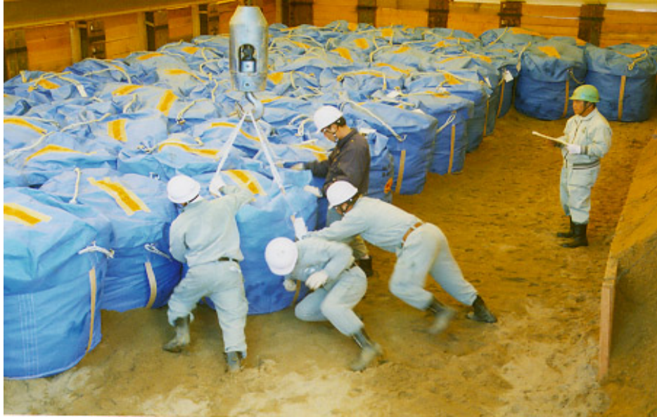
図 8 フレキシブルコンテナ封入廃棄物の定置作業状況
