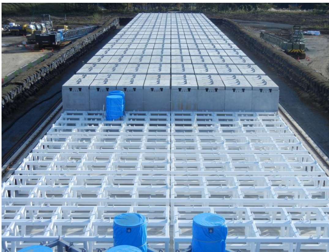
図 4.1-5 セシウム吸着塔一時保管施設の外觀 4.1-14)
