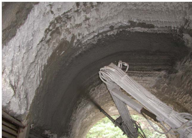
付図 2.2-7 HFSC 吹付コンクリートの模擬施工状況（原子力機構，2006）
