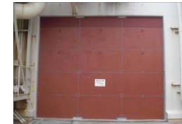
①止水板の設置
