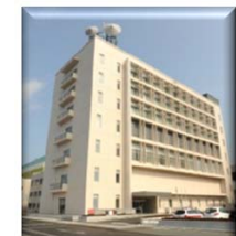
②緊急時の対策、通信等の重要設備を集めた耐震性の高い建物(免震重要棟)
