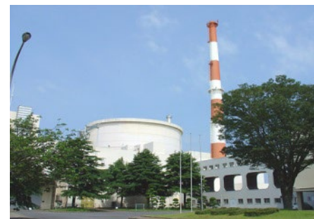
高速実験炉「常陽」
