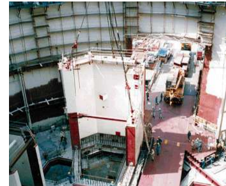
SC(鋼板コンクリート) 内部構造
