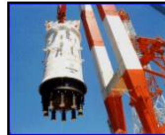
原子炉圧力容器据付
