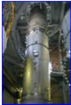
静的安全系試験設備
