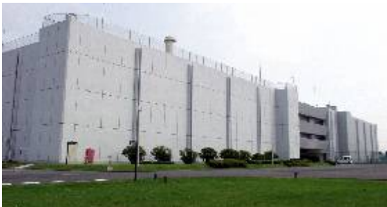
東海村 MOX燃料製造工場
