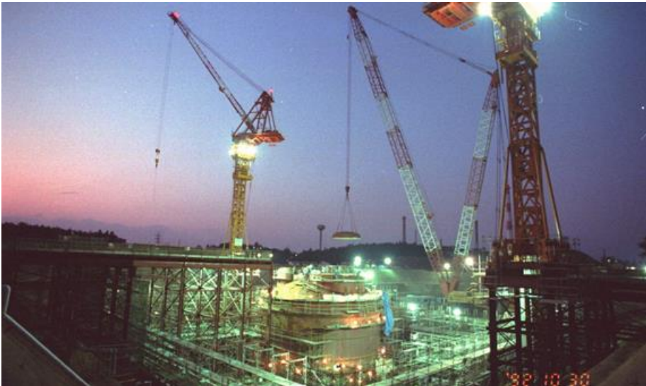
1992年10月 原子炉格納容器(CV)据付
