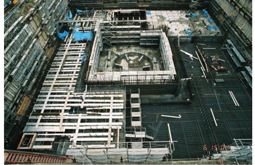
1992年4月 コンクリート打設状況
