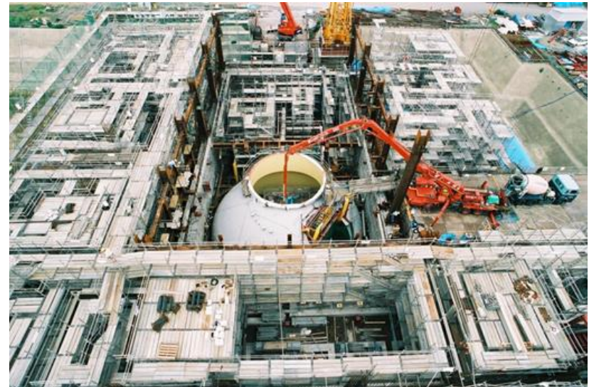
1993年7月 CV内部のコンクリート打設
