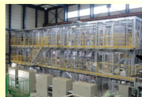
連続水素製造試験装置
