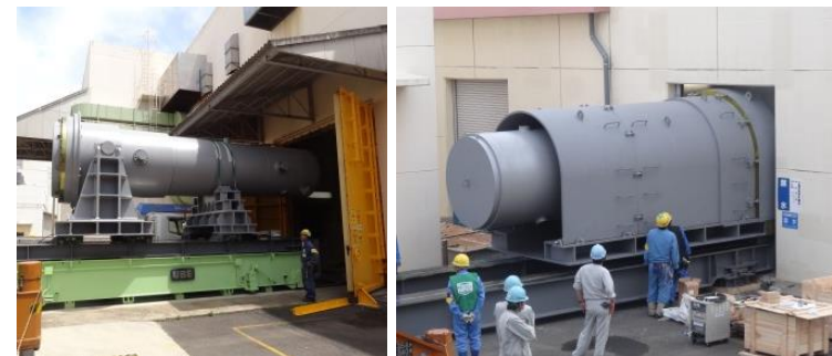
UCS移動・保管作業の様子
